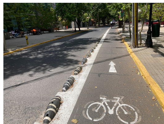
ブロックによる車道との分離（サンチアゴ）
